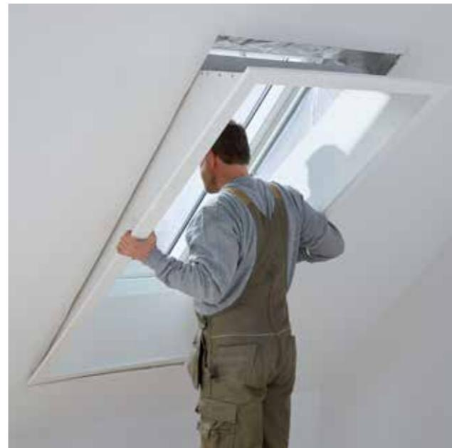
VELUX obloge su tvornički krojene prema dimenziji prozora pa će spajanje s ostatkom krovišta biti jednostavno i zrakonepropusno.
