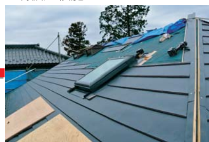
鋼板屋根施工
