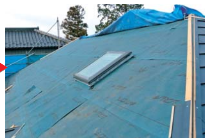
ルーフィング施工
