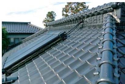
瓦 → ガルバリウム鋼板
