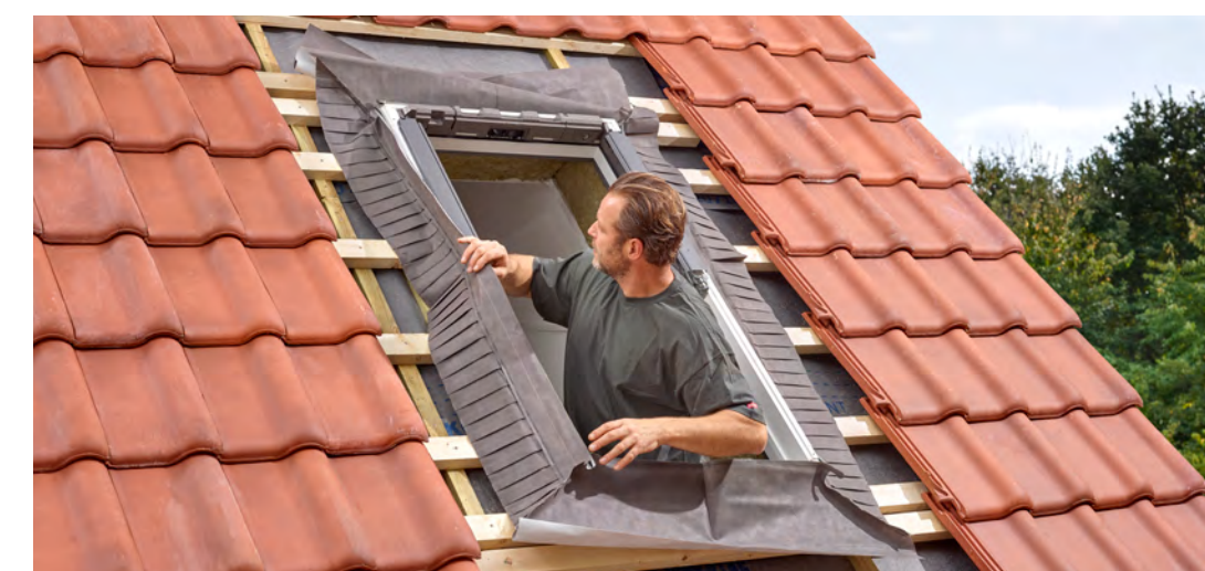
Montaż izolacji przeciwwilgociowej BFX oraz rynienki odwadniającej
