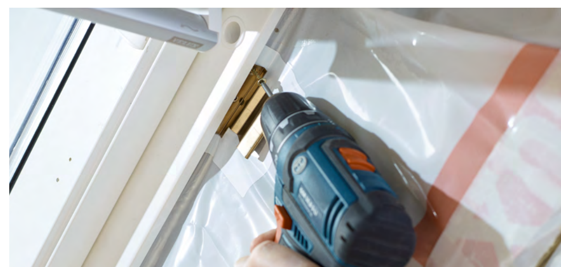
Montaż paroizolacji BBX
