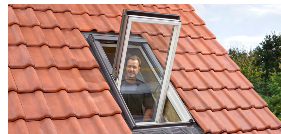
Włożenie skrzydła do ościeżnicy okna
