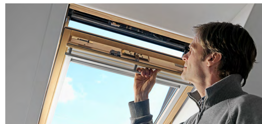
Sprawdzenie poziomych i pionowych szczelin między skrzydłem a ościeżnicą okna
