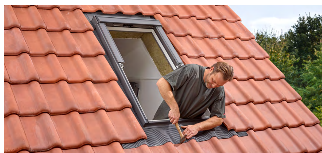
Montaż kołnierza uszczelniającego i wcześniej zdjętego pokrycia dachowego
