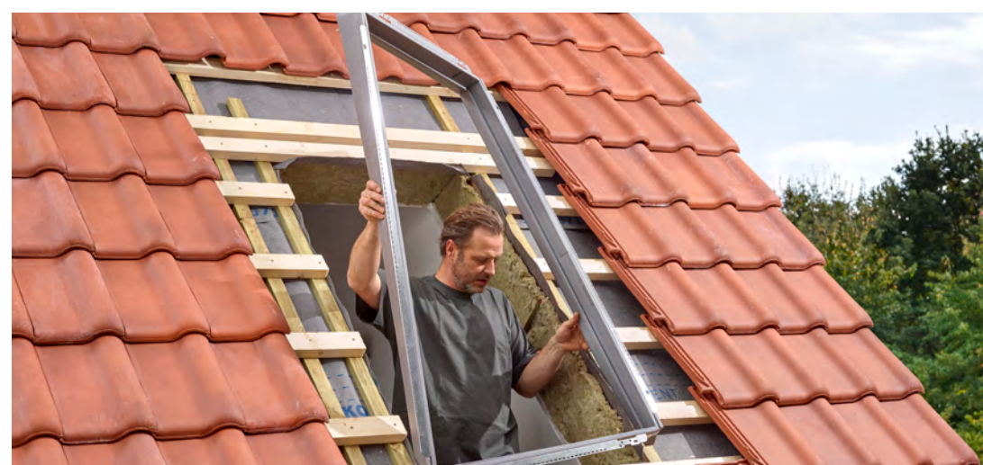
Montaż ramy izolacyjnej BDX wraz z ościeżnicą okna
