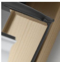
5 Garnitura suplimentara • Permeabilitate la aer clasa 4
